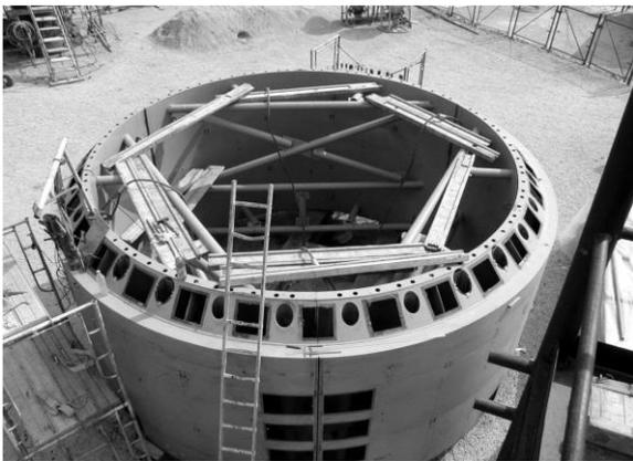
Рисунок 8 – Трехслойная сухая защита реактора в процессе возведения
