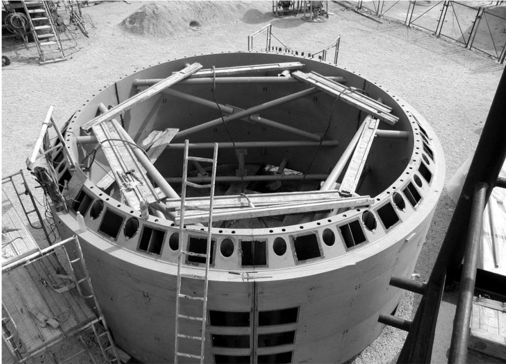
Рис. 3.6 – Трехслойная сухая защита реактора в процессе возведения [100]
