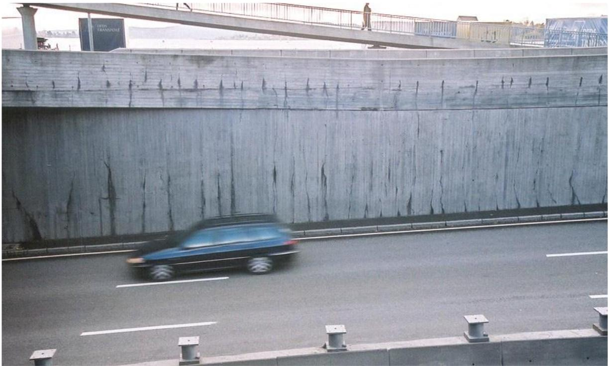
Рис. 1.2 – Пример трещин, вызванных внешним ограничением деформации
