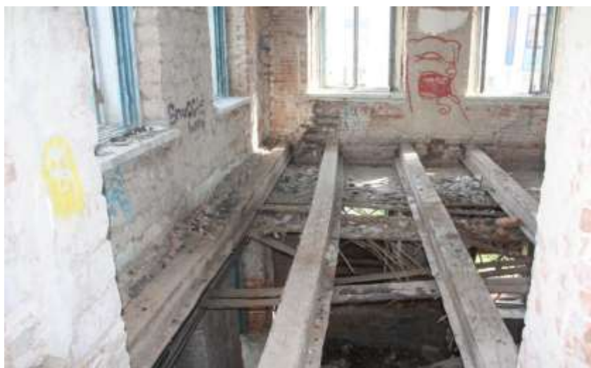
Рисунок 6. Фотофиксация деревянных балок перекрытия в помещении 2 этажа
