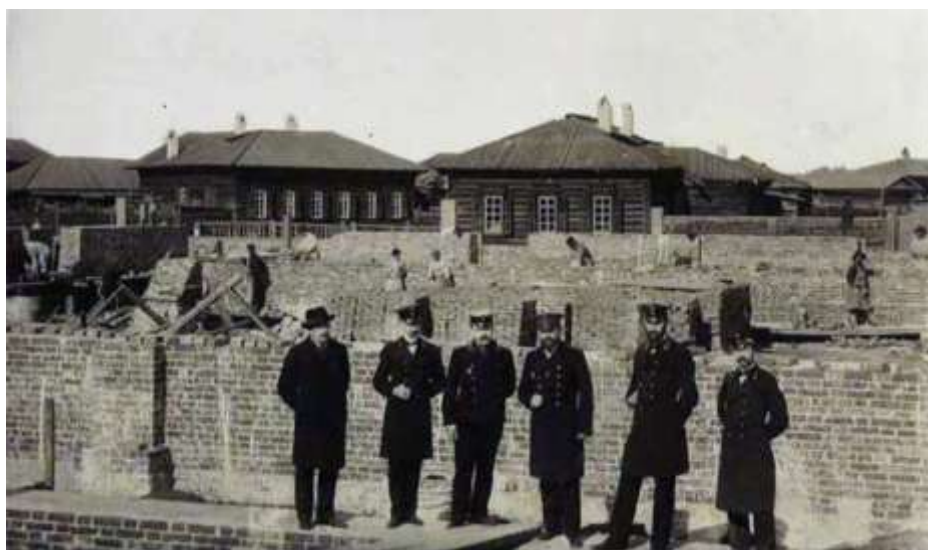
Рис. 3. Строительство Реального училища. 1908 г.
