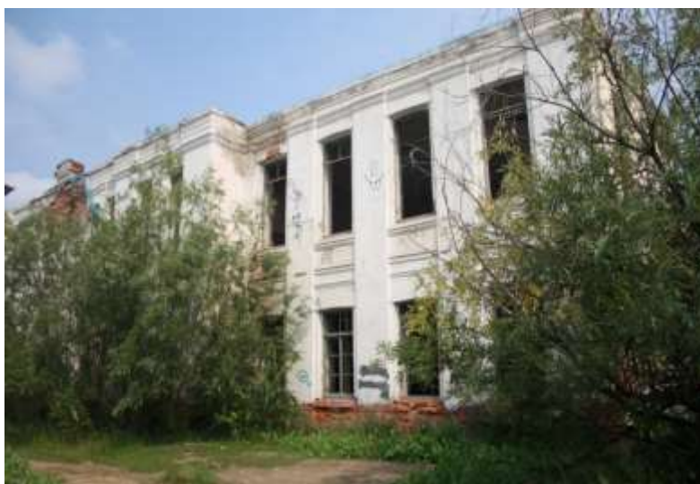
Рисунок 2. Здание реального училища, г Якутск. 2018г
